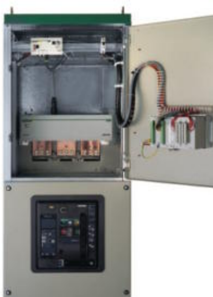
Störlichtbogenschutzsystem ARCON, eingebaut im System MODAN
